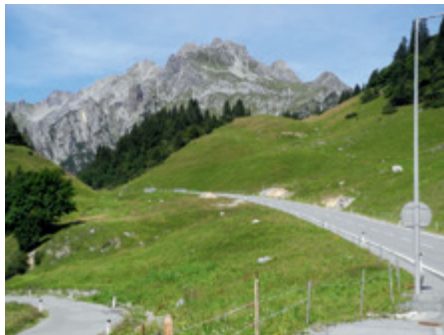
Links alte, rechts neue Arlbergstraße Richtung Zürs, Lech
